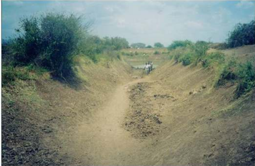
ဓာတ်ပုံ၏ နောက်ခံတွင်မြင်တွေ့နေရသော Charco dam ဆီသို့ရေဝင်လမ်းကြောင်းဖြစ်ပါ သည်။ အများအားဖြင့် ရေဝင်လမ်းကြောင်းတွင် မြေနင်းရန်နှင့် နန်းဖမ်းရန်အတွက် သစ်လုံး အချို့ ကန်လန်ဖြတ် ချထားလေ့ရှိပါသည်။
