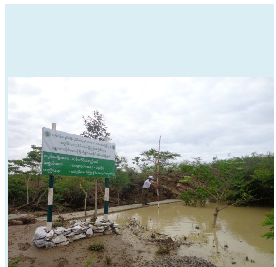
ဝမ်းတွင်းမြို့နယ်၊ ၂၀၁၃-၂၀၁၄ ဘဏ္ဍာနှစ် တစ်ဖက်ရပ်ဆည်ငယ် တည်ဆောက်ထားရှိပုံ
