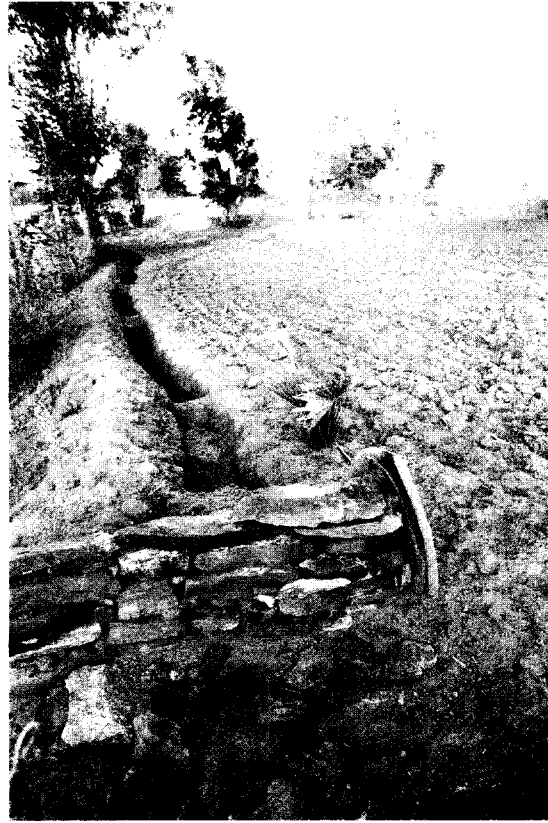
Lateral spillway (Kuley-Kyaukpadaung)
