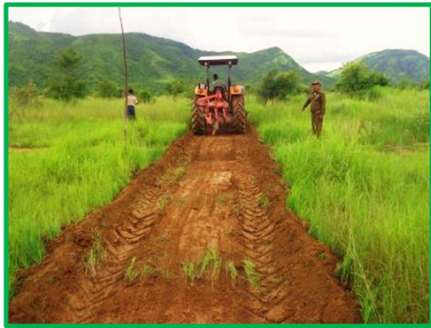
ပုံ (၁၃) - စက်ယန္တရားဖြင့် စစ်ဆေးလမ်းဖောက်လုပ်ခြင်းနှင့် လုပ်သားအင်အားဖြင့် ဖောက်လုပ်ထားသည့် စစ်ဆေးလမ်းအားတိုင်းတာစစ်ဆေးခြင်း
