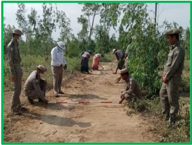
ပုံ (၁၃) - စက်ယန္တရားဖြင့် စစ်ဆေးလမ်းဖောက်လုပ်ခြင်းနှင့် လုပ်သားအင်အားဖြင့် ဖောက်လုပ်ထားသည့် စစ်ဆေးလမ်းအားတိုင်းတာစစ်ဆေးခြင်း
